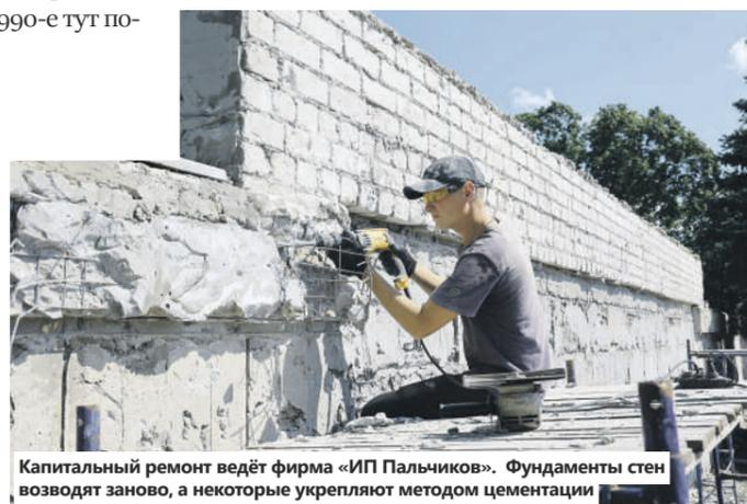
Капитальный ремонт ведёт фирма «ИП Пальчиков». Фундаменты стен возводят заново, а некоторые укрепляют методом цементации
